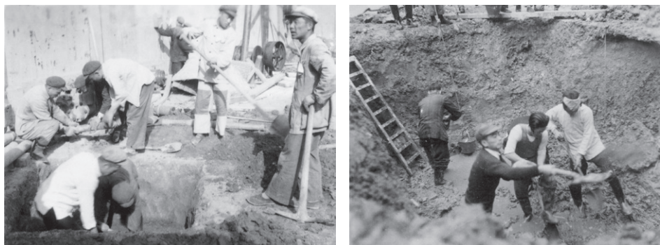
图 1-4 早期人防工程建设
