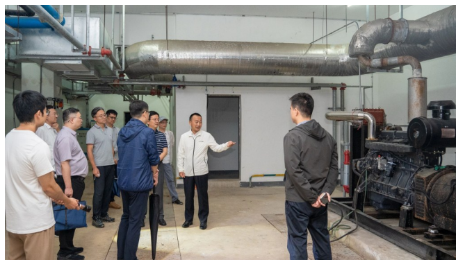
姜爱锋主任带队检查普陀区一人防工程现场
